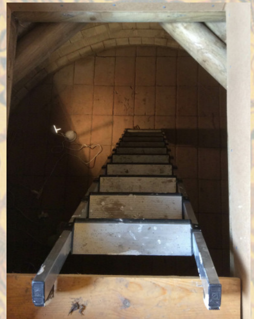
Der Einstieg in den Erdraum
